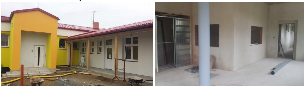
Exteriér a dokončovací práce v interiéru – květen 2015
