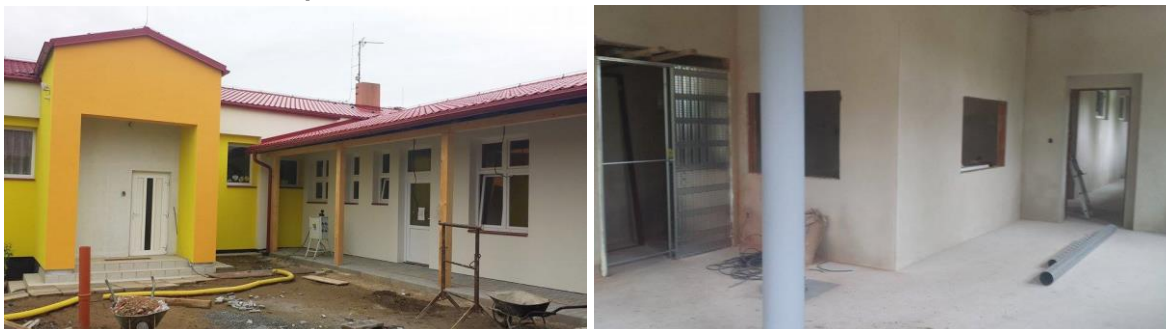
Exteriér a dokončovací práce v interiéru – květen 2015
